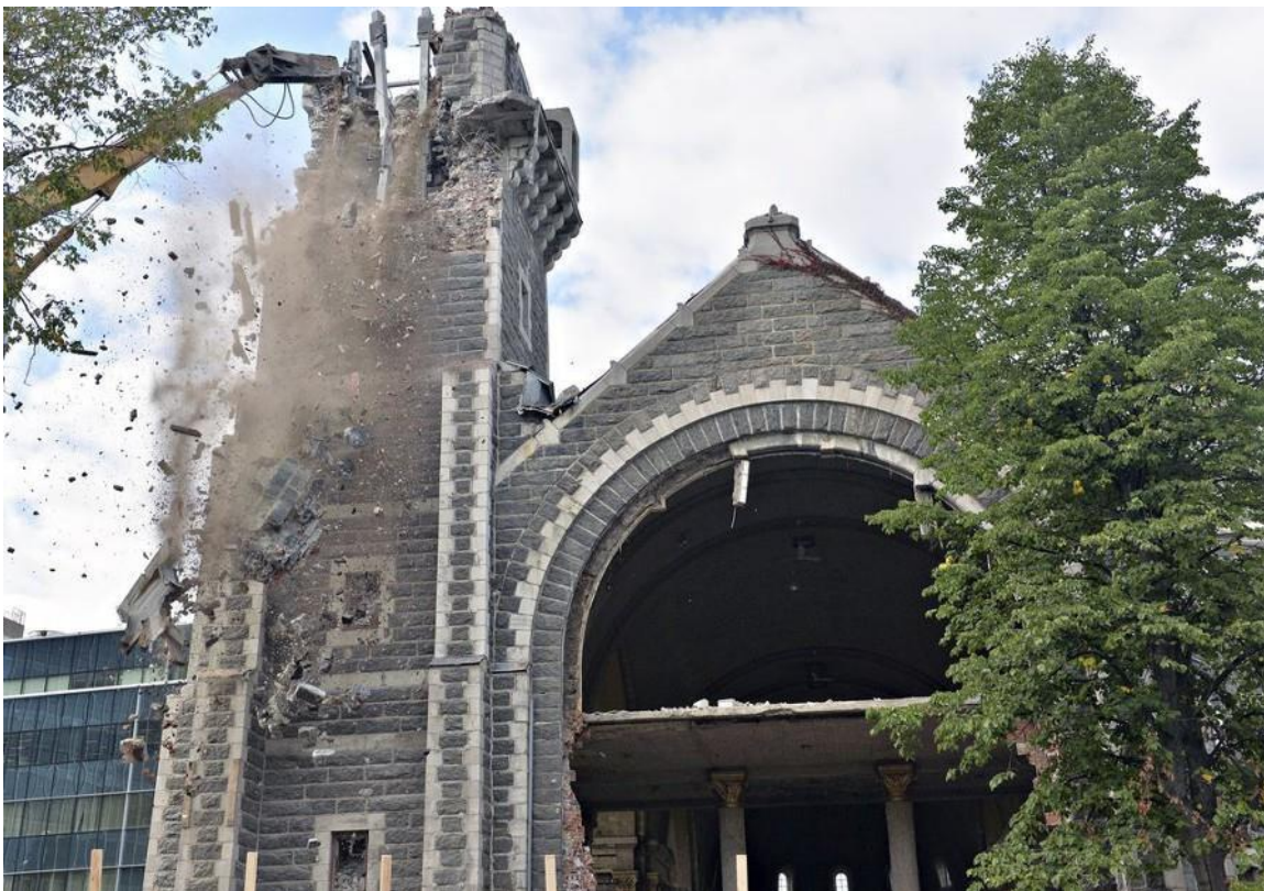
La démolition de l'église Sainte-Cœur-de-Marie en automne 2019
